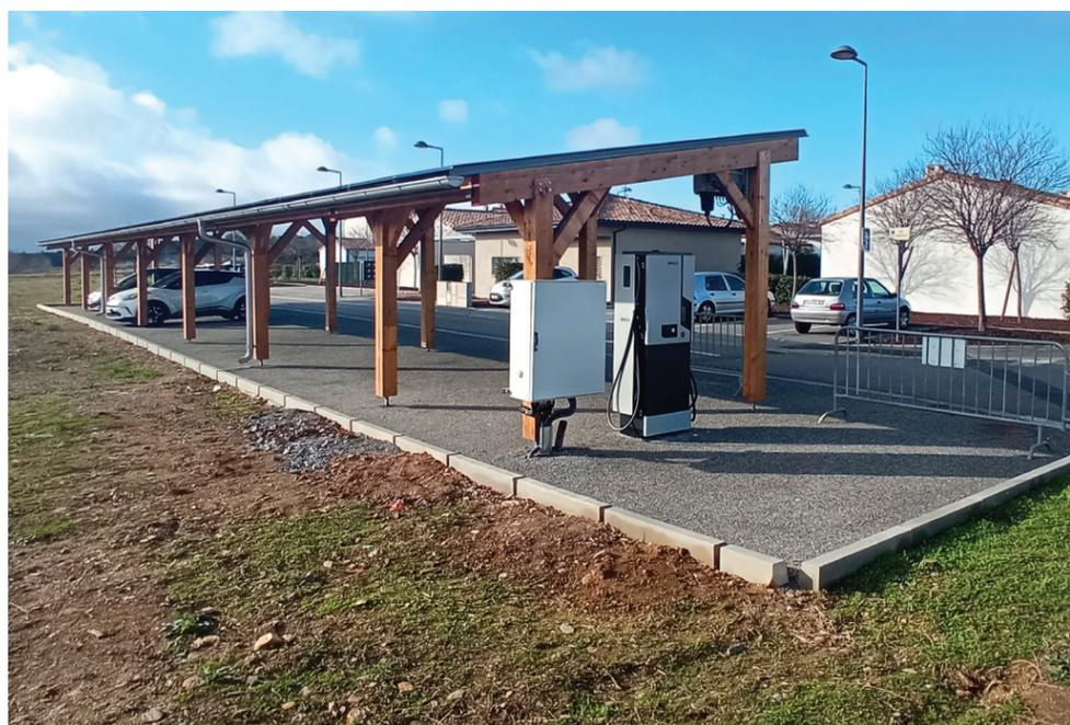
de charge rapide de 24 kW DC jusqu'à 100 kW DC sur des zones non desservies en IRVE de cette puissance couplée à une production photovoltaïque (PV) jusqu'à 100 kWc.
